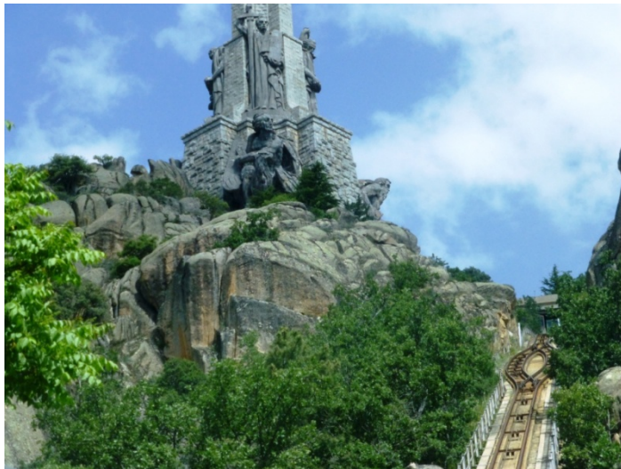
Im Verfall begriffen und gesperrt: Der Sockel des gigantischen Kreuzes. Foto: Rainer Huhle
